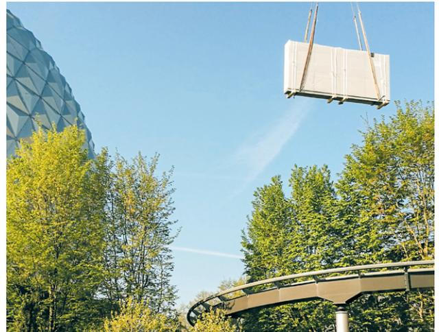
Üblicherweise können selbst Schaltschränke aus Anreihsystemen nur eine stark begrenzte Länge erreichen. Mit unserem selbst entwickelten, verstärkten Sockelsystem lassen sich nicht nur Schaltschränke mit einer Länge bis 4,80 m realisieren. Sie können diese Schaltschränke auch als eine Einheit transportieren und per Kran an ihrem Aufstellort platzieren.
